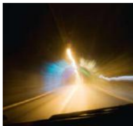
Den seks km lange tunnel til Klaksvik, Færøernes næststørste bygd, er lysat i forskellige farver
